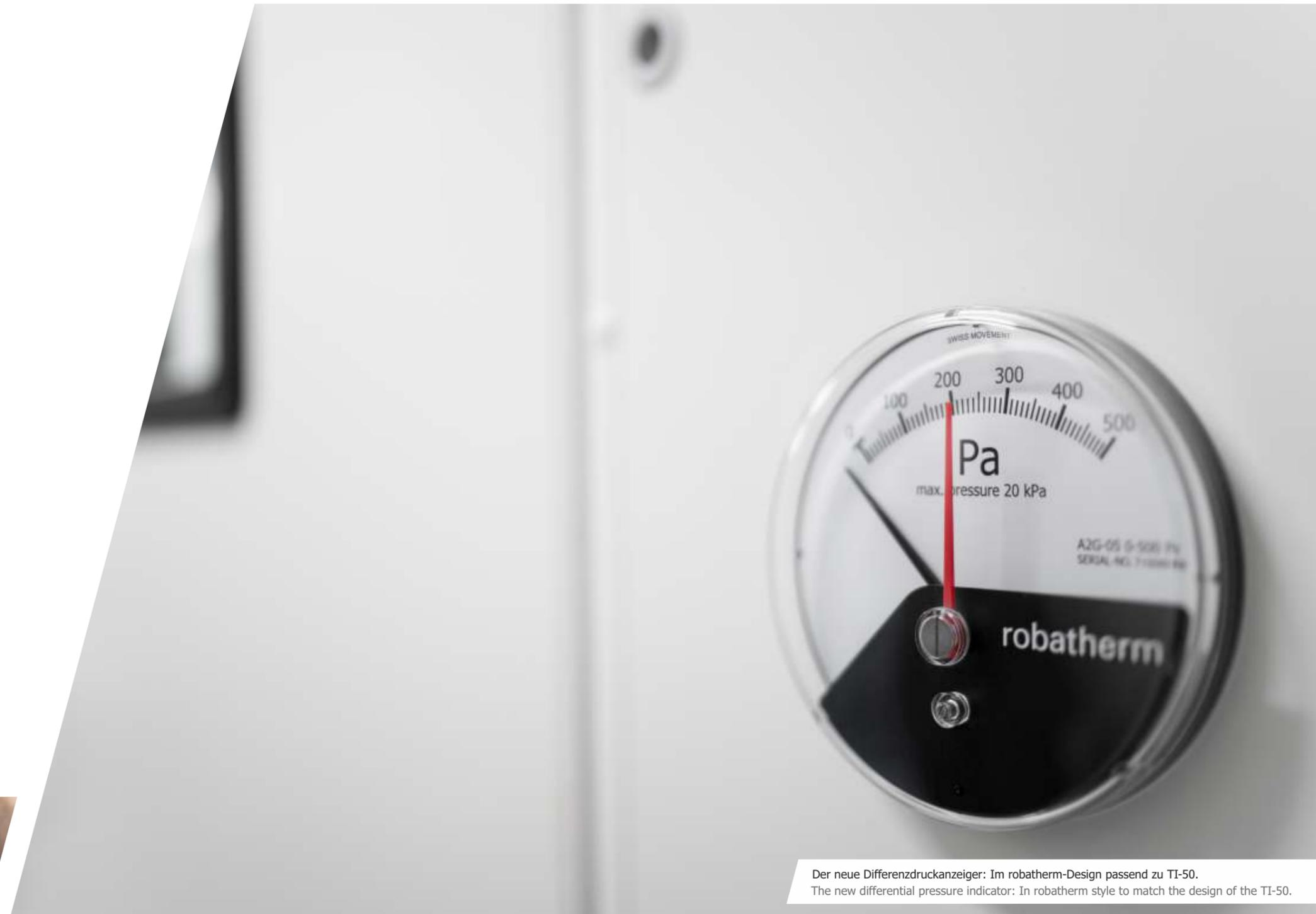
Der neue Differenzdruckanzeiger: Im robatherm-Design passend zu TI-50.
