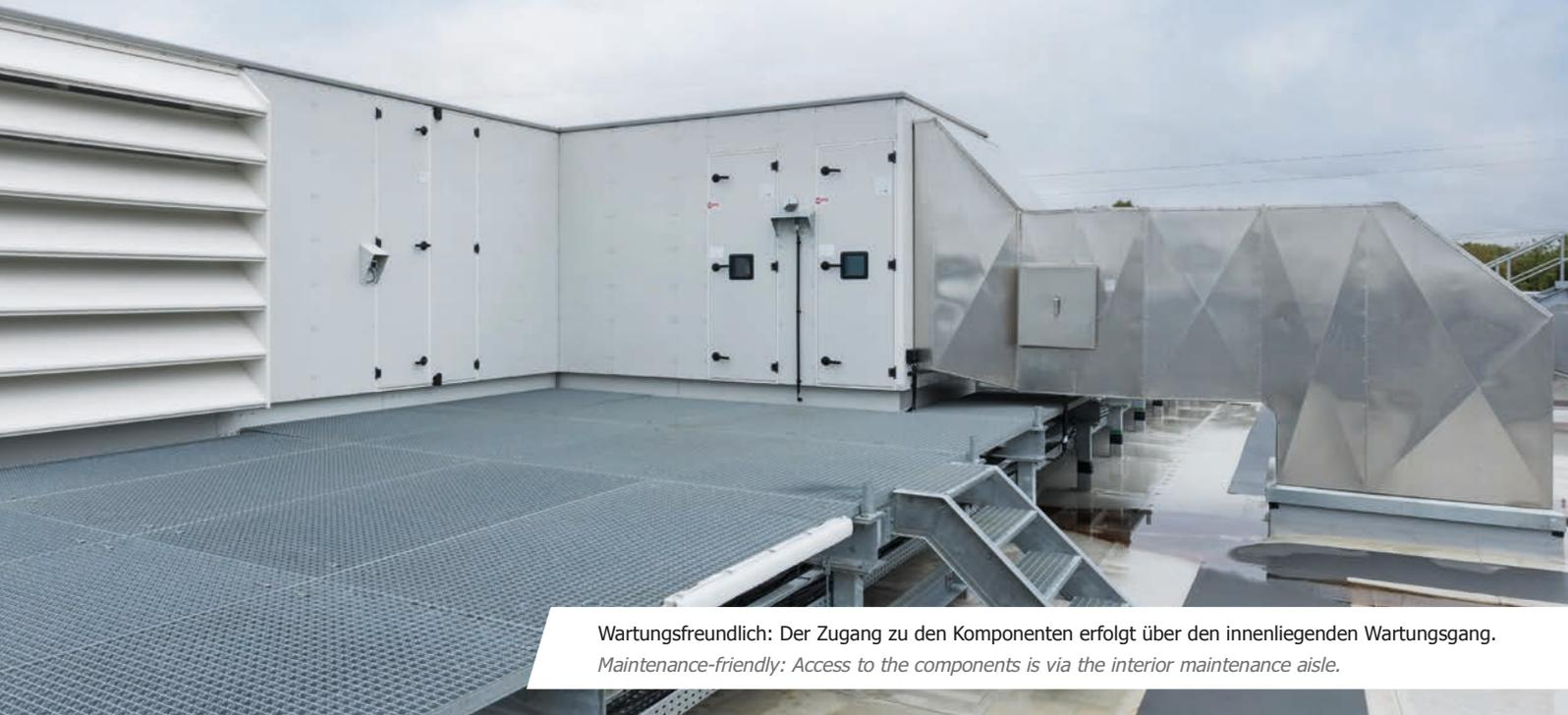
Wartungsfreundlich: Der Zugang zu den Komponenten erfolgt über den innenliegenden Wartungsgang.
