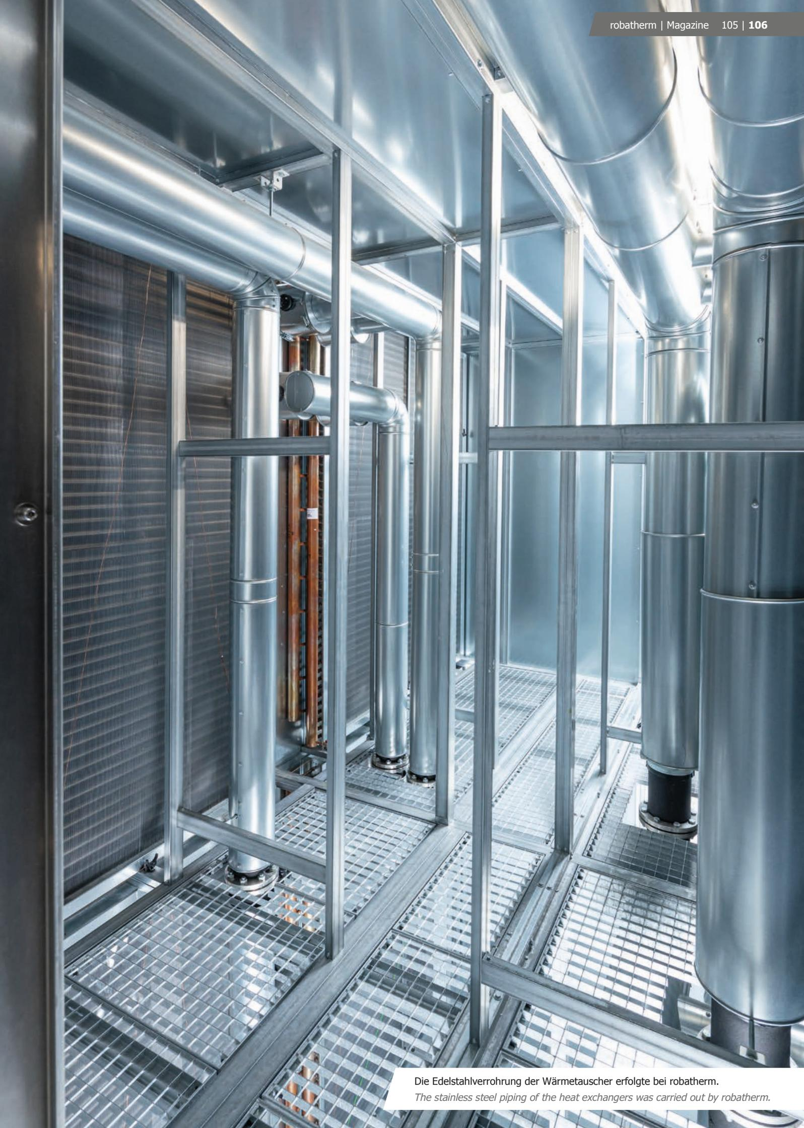
Die Edelstahlverrohrung der Wärmetauscher erfolgte bei robatherm.
