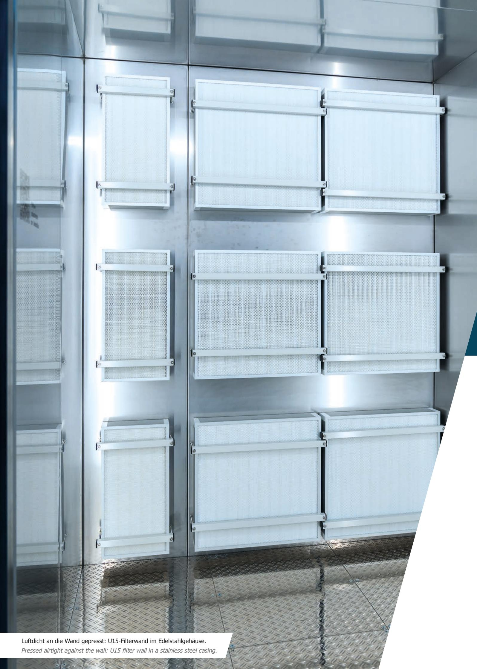
Luftdicht an die Wand gepresst: U15-Filterwand im Edelstahlgehäuse.
