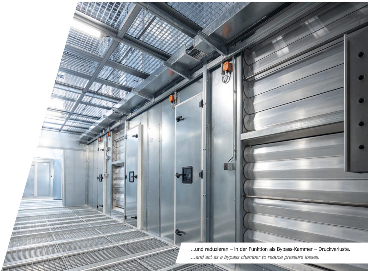
...und reduzieren – in der Funktion als Bypass-Kammer – Druckverluste.
